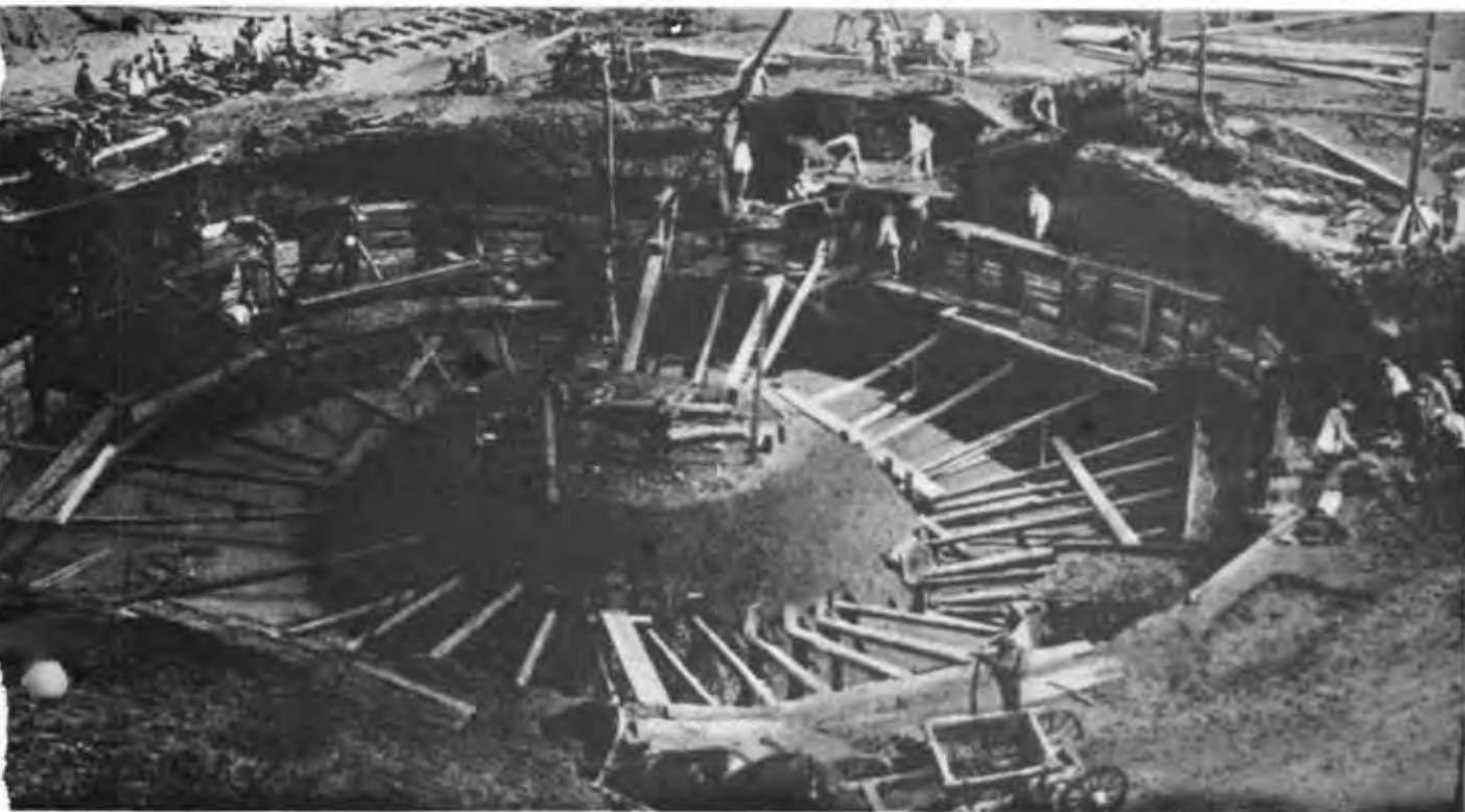
Fundament des ersten Hochofens in Magnitogorsk. Zu der Zeit gab es dort keine einzige Maschine.
