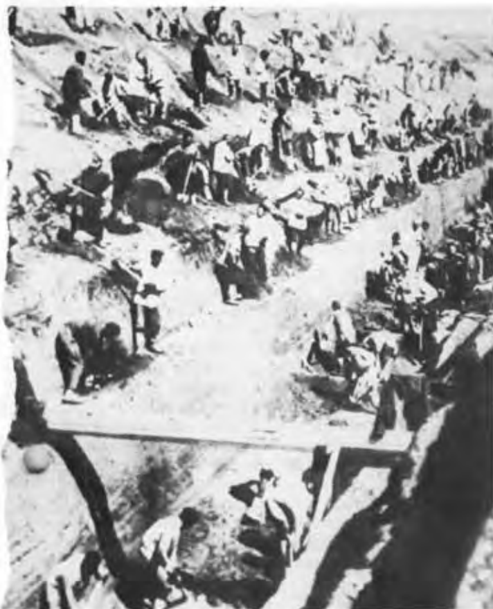
Mit primitivsten Mitteln wird 1939 in Usbekistan ein Kanal ausgehoben.
