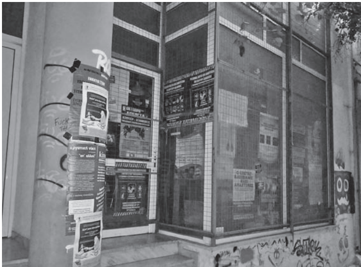
Das gut gesicherte Büro der Basisgewerkschaft SVEOD
