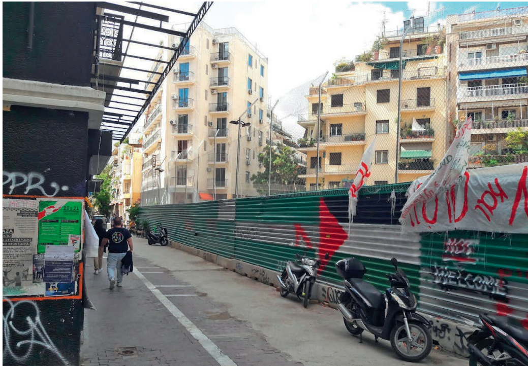
Für den Bau der Metrostation abgeriegelter Platz im Herzen von Exarchia
